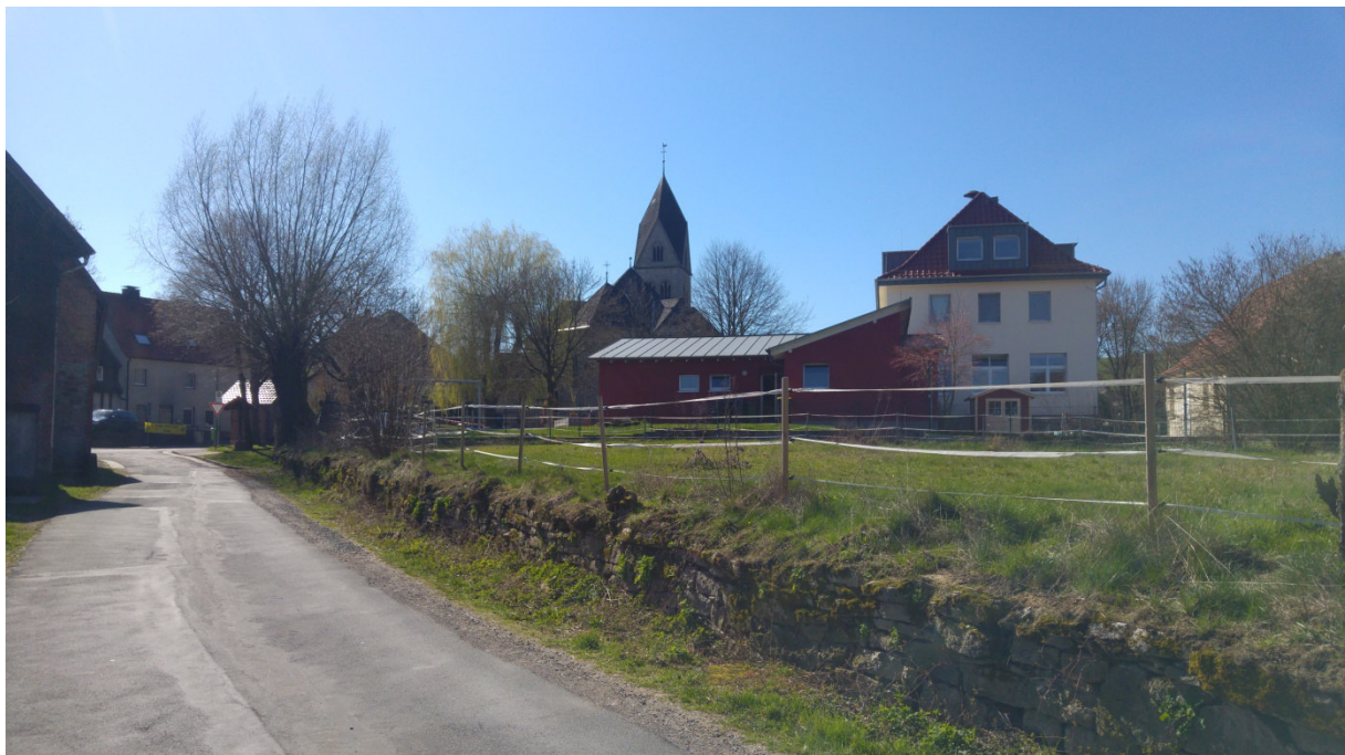
Bruchsteinmauer am Grst. 4/235
