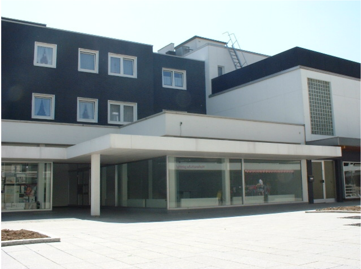
Abbildung 5: Leerstand und unattraktive Bausubstanz in Fußgängerzone
