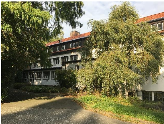
Foto 1: Bereich der Eggelandklinik der abgerissen wird. Dach und Fenster intakt. Vorkommen des Waschbären im Dachstuhl.
