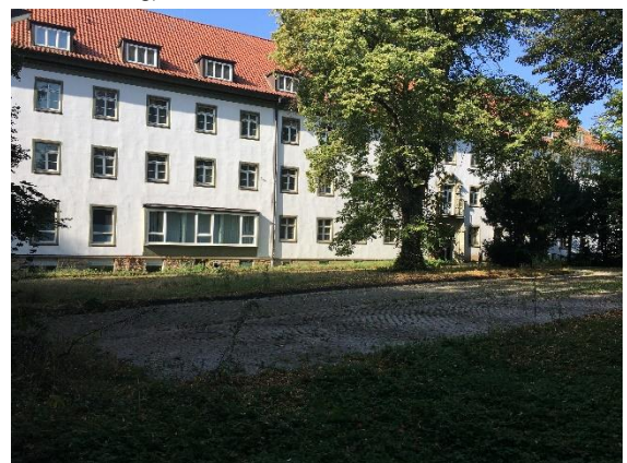
Foto 4: Klinikhauptgebäude und die Bäume davor bleiben erhalten.
