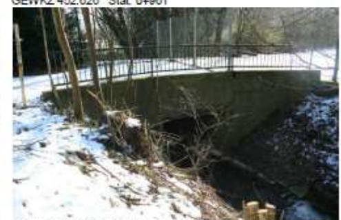
GEWKZ 452.626 Stat. 0+965 in Fließrichtung Brücke
