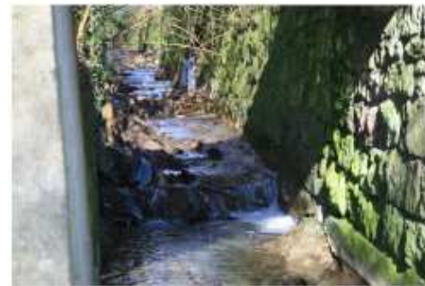
GEWKZ 452.626 Stat. 0+896 Sohlabsturz 0,4 m
