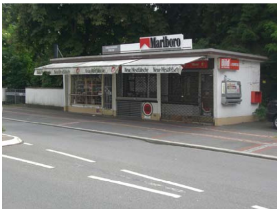
Abbildung 6: abgängige Bausubstanz mit Mindernutzung
