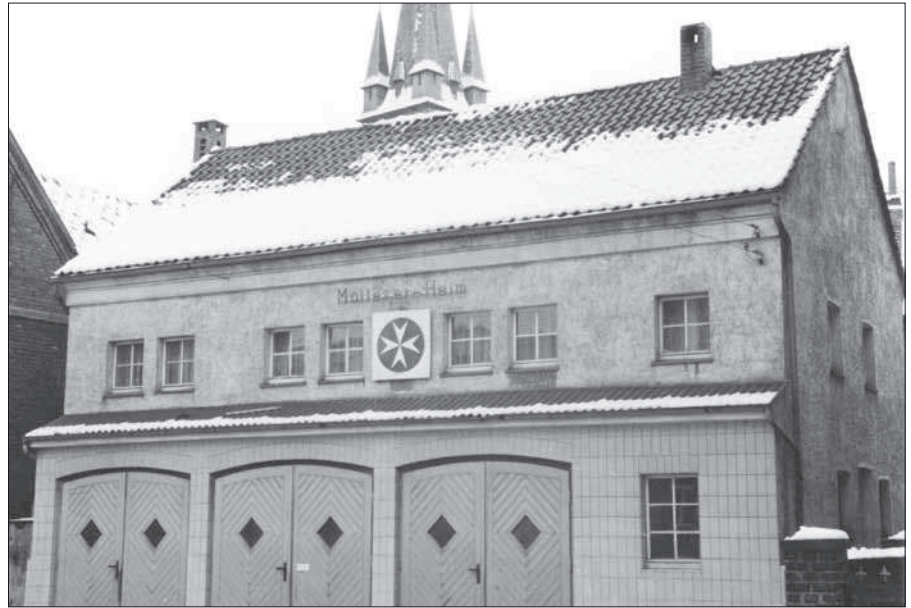
Synagogengebäude als Garagen und Aufenthaltsraum des Maltesserhilfsdienstes; 1960er Jahre Foto: Klaus Grimm
